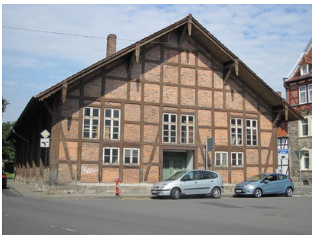
Jahnturnhalle in Wolfenbüttel.
